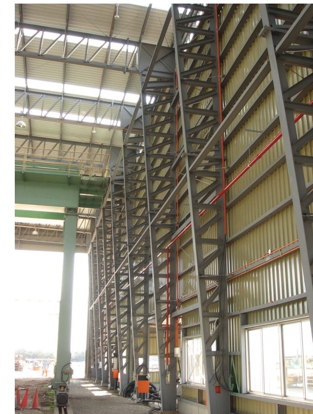
システム建築(ラチスタイプ)内観
