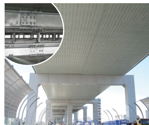
高速道路の裏面吸音板支持梁
